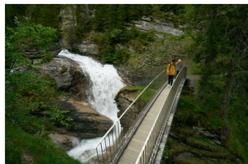
Brücke über die Flem
